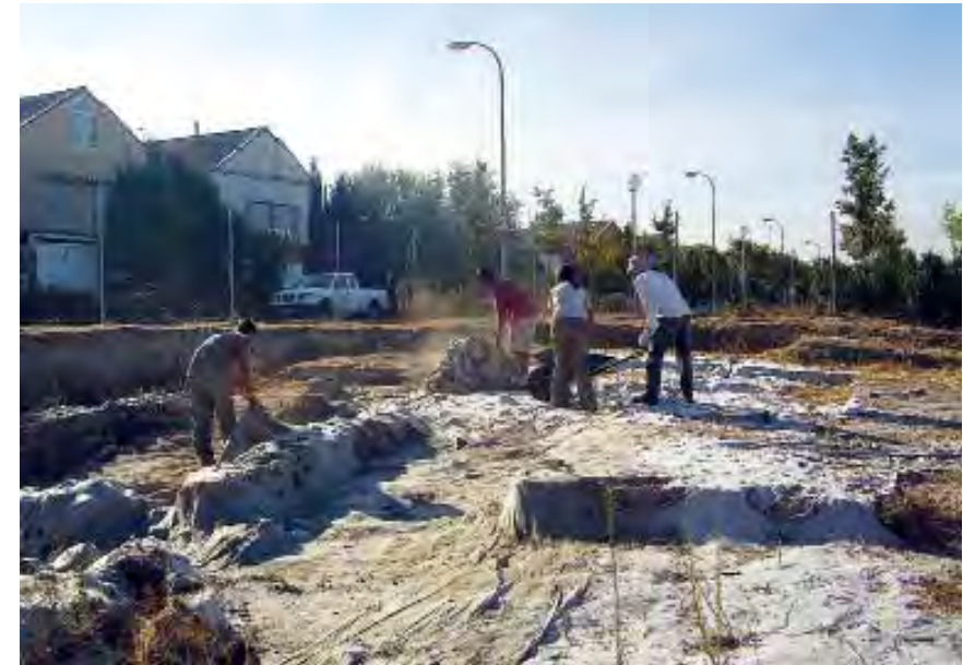
Figura 4. Retirada de geotextil. Año 2006.
